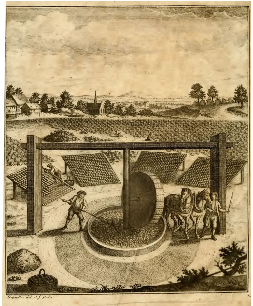
Afbeelding uit: D. Schrebers, Historische, physische und öconomische Beschreibung des Waidtes (Halle 1752). Op de voorgrond worden de wedebladeren verpulpt in een rosmolen. Daarachter worden wedeballen te drogen gelegd. Helemaal op de achtergrond is het oogsten van het blad afgebeeld.
